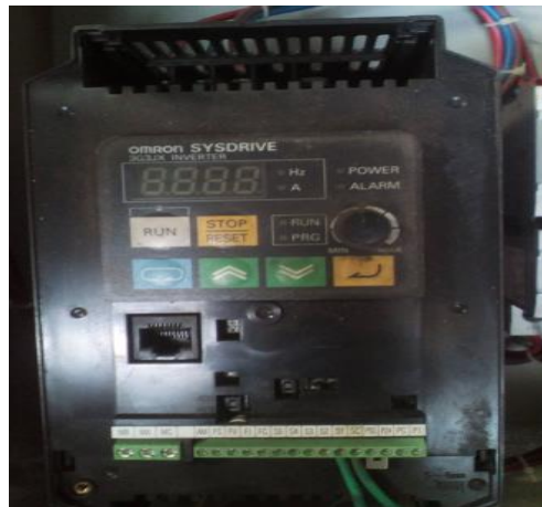
Hình 4.11. Biến tần điều khiển tốc độ
